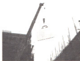
速成墙板吊装中
